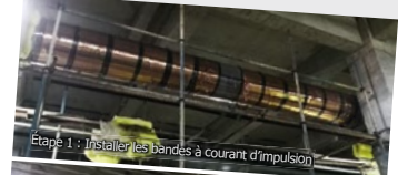
Étape 1 : Installer les bandes à courant d'impulsion
