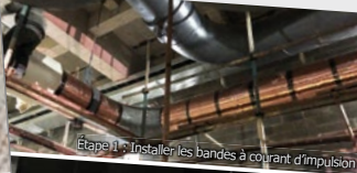
Étape 1 : Installer les bandes à courant d'impulsion
